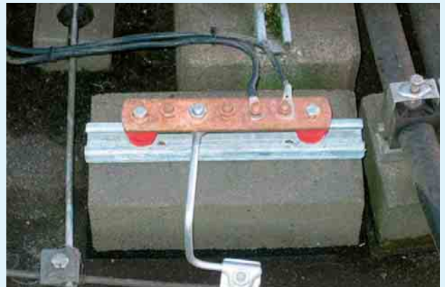
1 Potentialausgleich im Außenbereich für Antennenkabel und Antennentragwerke
