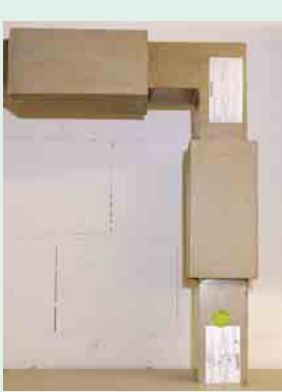
5 Die Anschlussstücke an der NS-Schaltanlage sowie am Transformator werden bereits von den entsprechenden Lieferanten verbaut. Das beschleunigt die Schieneninstallation auf der Baustelle Fotos: Siemens
