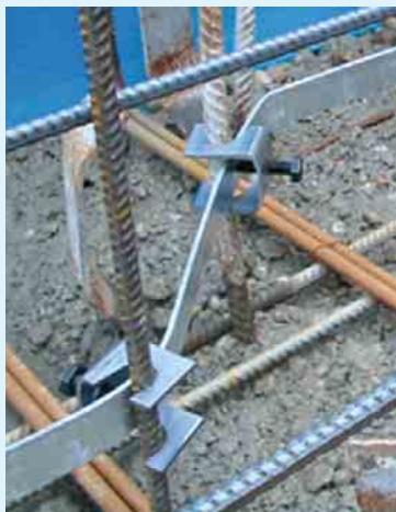
⑩ Verbindung Bandstahl mit Bewehrung
