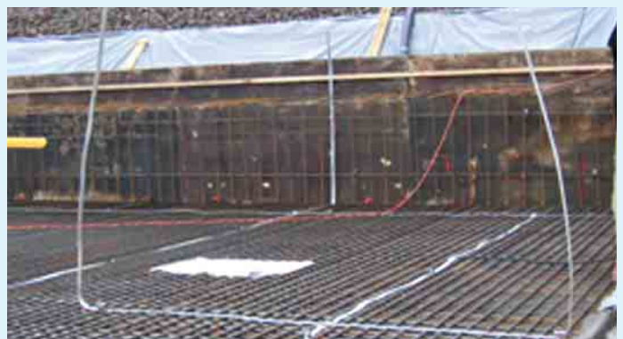
2 Keilverbindung ist bei Rüttelbeton nicht zulässig
