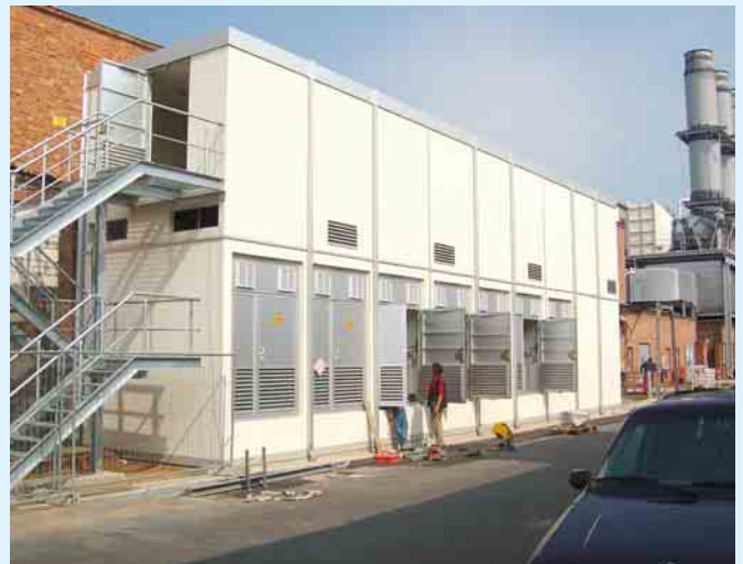
③ Beispiel für eine typgeprüfte Schaltanlage als Fertigstation ▶
