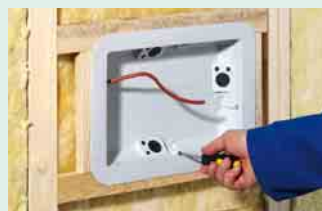
3 Befestigung erfolgt über Laschen
