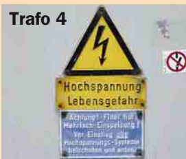
2 Warnschild für Mehrfacheinspeisung
