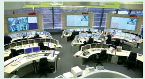
1 Neue Betriebszentrale auf dem Dach des Hochbahn-Hauses
