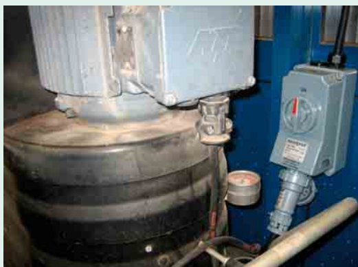
1 Steckvorrichtung in einem Bereich, in dem brennbare Staub-/Luftgemische entstehen können Foto: Mennekes
