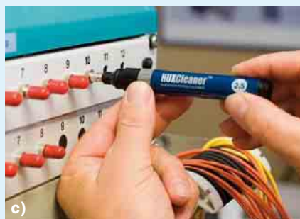
⑤ Reinigung der Steckerstirnflächen mit a) hochreinem Alkohol, b) einer Mikrofaser-Bandkassette und c) mit einem speziellen Reinigungsgerät; das Teilbild d) zeigt die saubere Steckerstirnfläche nach der Reinigung Fotos: bfe-Oldenburg
