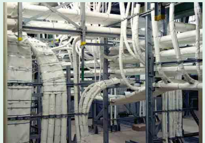
1 Objektbeispiel – horizontale und vertikale Kabelanlagen mit innerer und äußerer Bandagierung
