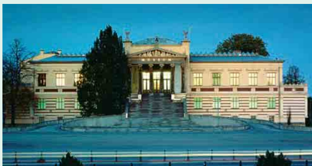
4 Auch das Staatliche Museum Schwerin beweist, dass in historischen Gebäuden moderne Gebäudeautomation möglich ist
