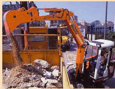
1 Minibagger beim Ausschachten eines Kabelgrabens
