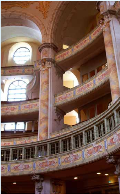
② Emporen mit offener Bogenkonstruktion
