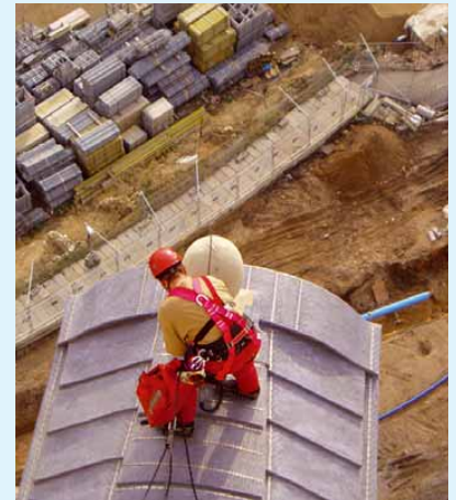
③ Leuchtmittelwechsel im Strahler auf dem Gaupendach
