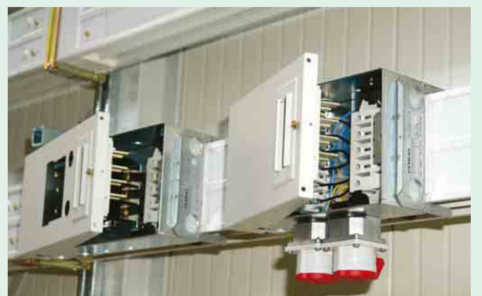
⑤ Abzweige lassen sich in definierten Abständen je nach Ausführung stecken und ziehen
