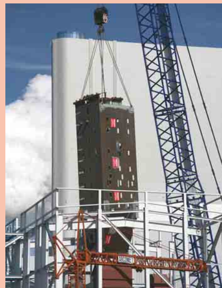
1 Kesselmontage am 20.09.2007 für das CO 2 -arme Kohlekraftwerk am Standort Schwarze Pumpe
