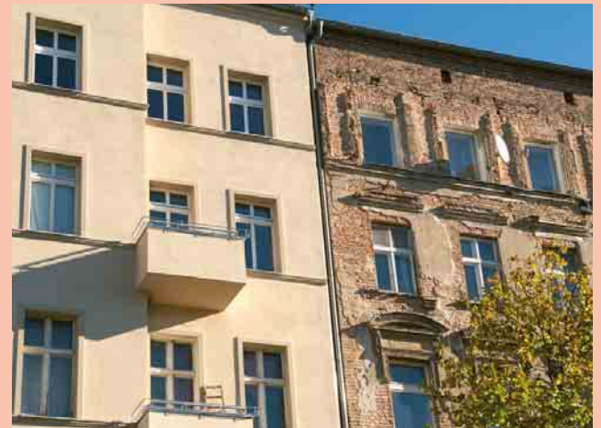
2 Den größten Beitrag zur Reduzierung der Treibgas-Emissionen im Gebäudebereich liefert die energetische Sanierung von Altbauten
