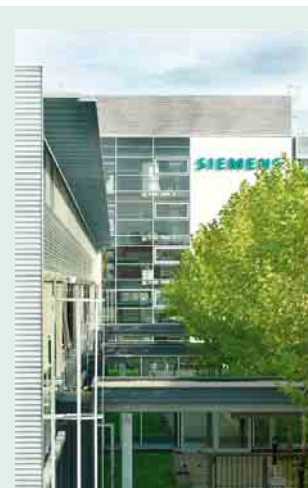
1 Siemens-Werk für Kombinationstechnik in Chemnitz
