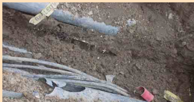
2 Von einer Kabelbettung in Sand oder steinfreier Erde kann hier nicht die Rede sein
