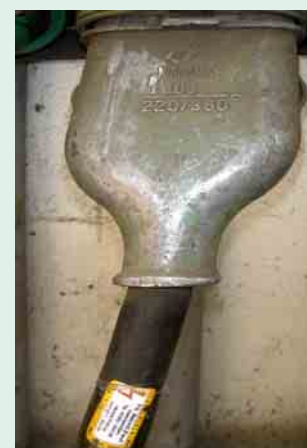
❷ Prüfsiegel auf der Verbindungsleitung einer Kragensteckdose
