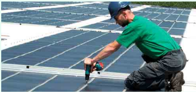
② Auf Trapezblechen wird das Modul quer zur Abflussrichtung auf der nicht wasserführenden Obersicke montiert
