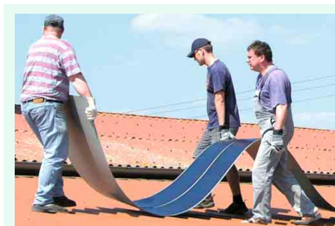
1 Glasfreie Dünnschichtmodule sind flexibel und nicht zerbrechlich
