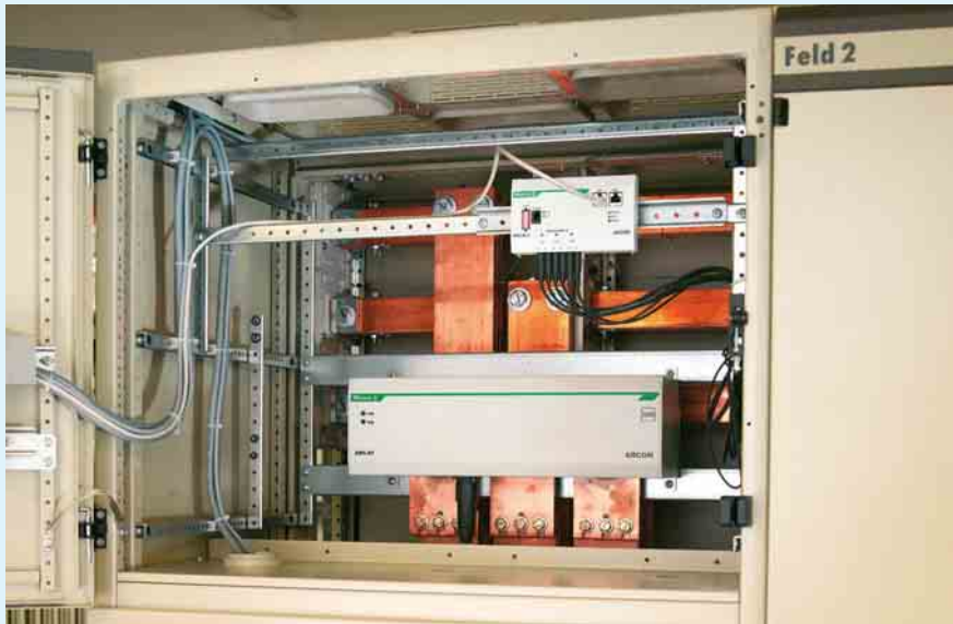
⑩ Lichtbogenlöschgerät
