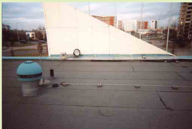
2 Blitzschutzleitungen parallel zur Attika und über Stecker angeschlossener Flutlichtscheinwerfer
