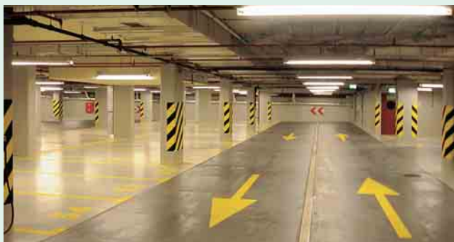
❷ 24-h-Anwendung in einer Tiefgarage
