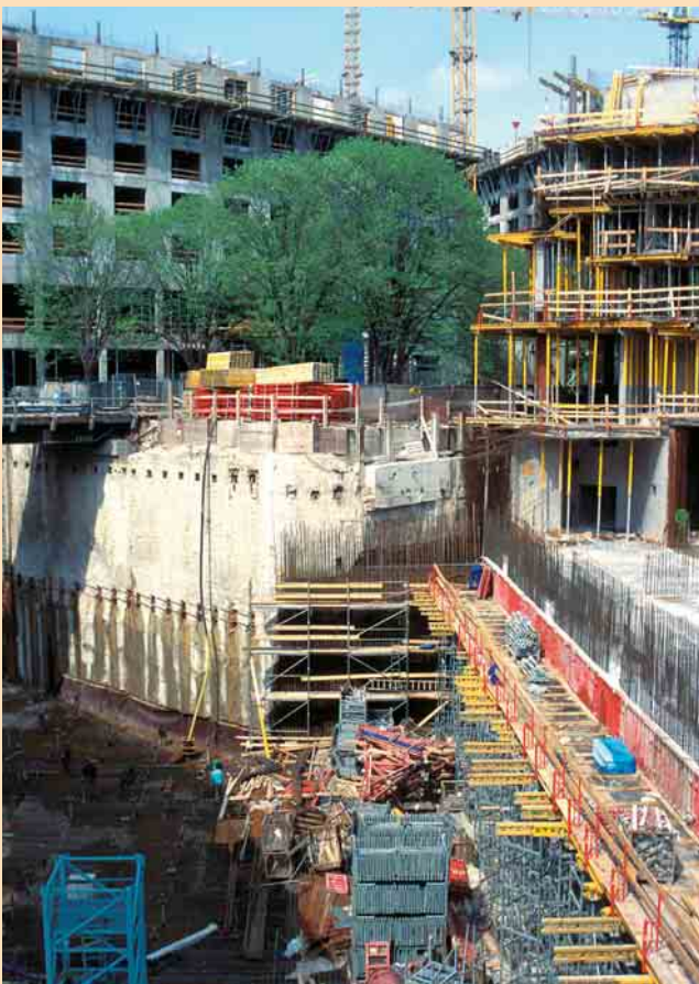
③ Schon während der Bauzeit muss die Feuerwehr alle Punkte einer Baustelle erreichen können. Nicht nur Brände, sondern auch technische Hilfeleistungen oder Rettungsdiensteinsätze können den Zutritt erforderlich machen
