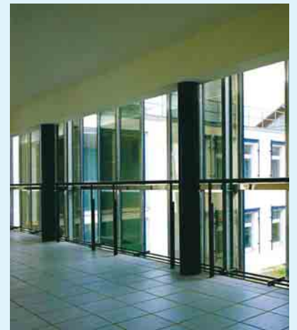
b) Semitransparente Dünnschicht-Solarmodule aus amorphem Silizium-Glaselement Foto: Schott Solar
