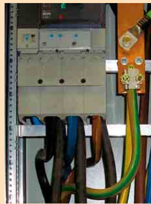
③ Brücken am Leistungsschalter
