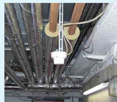
2 Kabelschutzbeschichtung im Bereich der Trasse, der Befestigungen und der Einzelkabel auf der Wand
