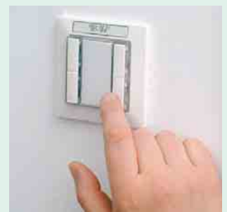
2 In den Büro- und Nutzräumen können über UP22x-Taster aus dem Delta-i-System Beleuchtung und Jalousien individuell geschaltet werden
