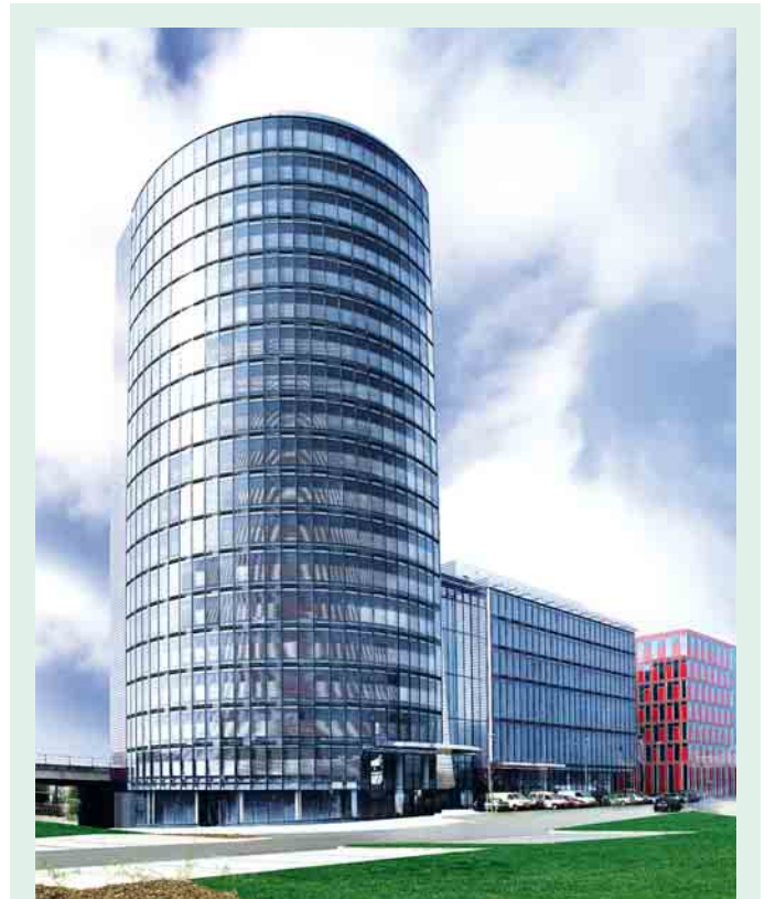
1 Außenansicht des Düsseldorfer Media Towers
