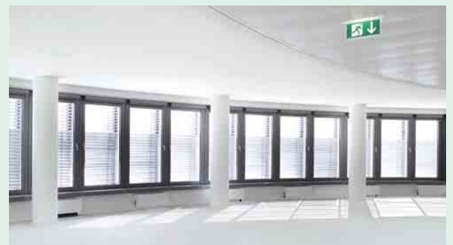
2 In die Büroräume gelangt trotz Sonnenschutz ausreichend Tageslicht
