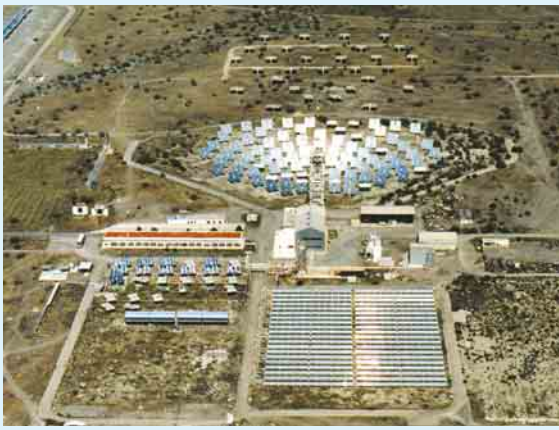
② Testgelände PSA in Spanien. Deutlich erkennbar sind das Turmkraftwerk und die Parabolrinnenkollektoren. Foto: PSA
