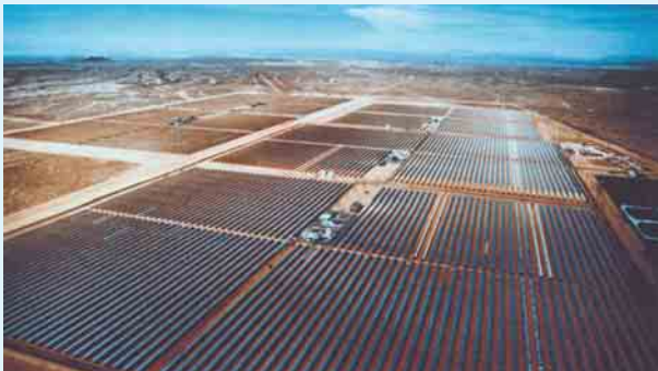
④ Luftaufnahme von fünf 30-MW-Kraftwerken, ein Teil der in Kalifornien installierten neun Dampfkraftwerke Foto: SEGS
