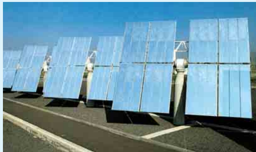
7 Mehrere 100 bis über 1000 solcher 10x10 m großen Spiegelflächen gehören zu einem Solarturmkraftwerk. Diese Heliostaten werden der Sonne computergesteuert dauernd nachgeführt.
