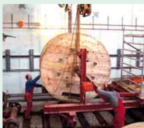
⑤ Für den Wechsel der Kabeltrommeln sind zwei umgebaute Bagger notwendig
