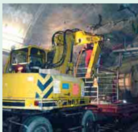
④ Die Bagger dienen zugleich als Kabelzuführung für das Montageteam
