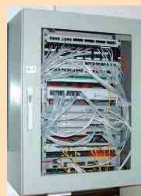
7 19"-Schrank mit vollständiger Bestückung
