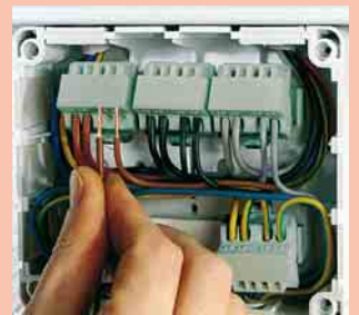
10 Kabelabzweigkasten Fa. Hensel
