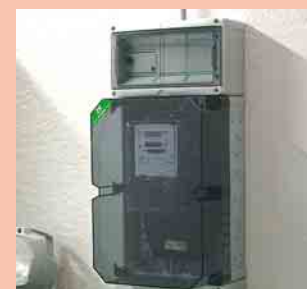
17 Automaten- und Zählergehäuse Fa. Spelsberg
