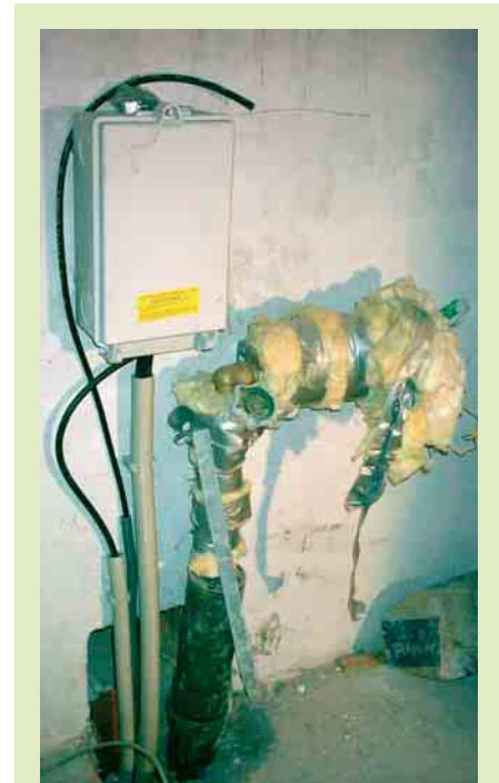
1 Akzeptable Ausführung eines Hausanschlusses
