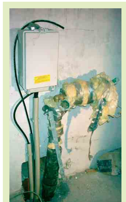
❶ Akzeptable Ausführung eines Hausanschlusses
