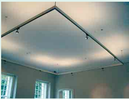
③ Jede der drei Lichtschienen ist einzeln schaltbar und kann individuell mit unterschiedlichen Leuchten und Strahlern für eine Akzentuierung bestückt werden.
