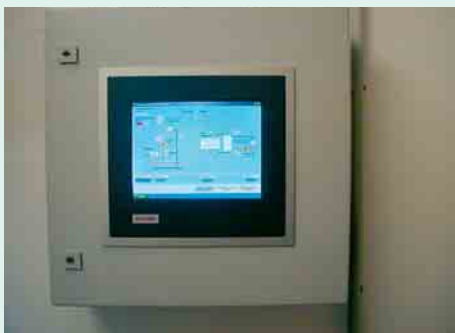
⑤ 12-Zoll-Einbau-Control-Panel CP6801 mit Touchscreen
