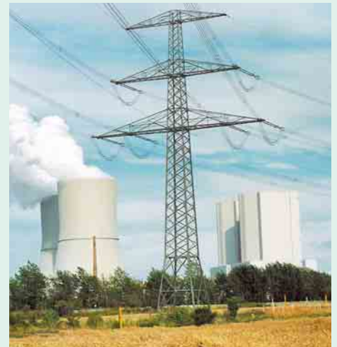
❶ Großkraftwerk Lippendorf, 15 km südlich von Leipzig
