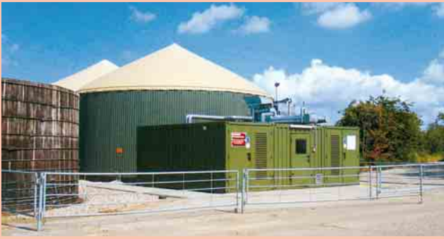
⑤ Durchflussbiogasanlage mit integriertem Gasspeicher, BHKW-Container und Gärrückstandslager
