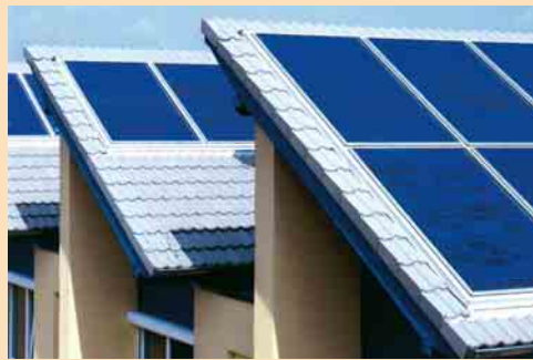
② Indachmontage – Solargeneratoren harmonisch integriert in die Dachhaut Foto: Schüco
