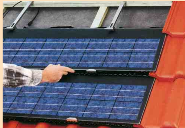
3 Einsetzen von Ziegel-Modulen des System PV 1800 in die Dachhaut
