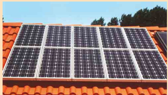
1 0,5-kW p -Solargenerator auf dem Dach eines versorgungsnetzfernen Gartenhauses (Quelle: Solinus)
