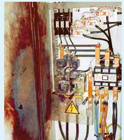
1 Folgen durch einen falsch ausgewählten Überspannungsableiter in der Verteilung einer Windkraftanlage
