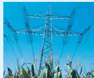
6 Freileitungen für zwei Drehstromkreise an einem Donaumast
