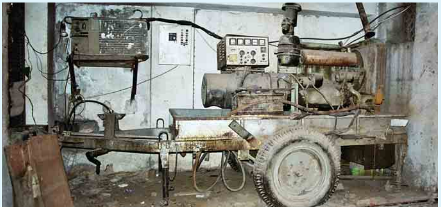
❶ Ersatzstromaggregat, das seinen Aufgaben nicht genügen kann
