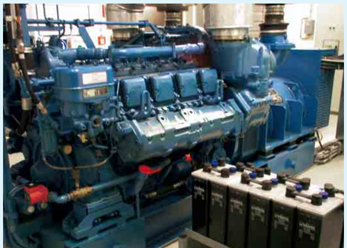
❶ Ersatzstromaggregat, das seinen Aufgaben nicht genügen kann
