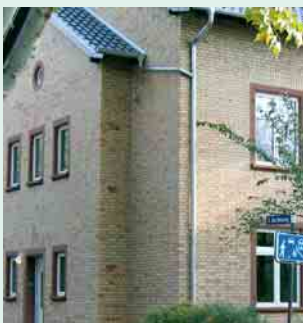
❶ Auch alte Gebäude lassen sich auf Niedrigenergie-Standard sanieren
