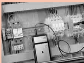
③ Überprüfung eines SPD-Moduls mit RFID-Technik (LifeCheck)
