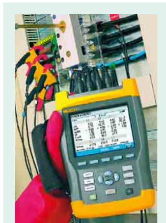
4 Messung aller drei Außenleiter und des Neutralleiters
