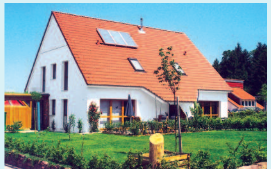
1 Solarthermieranlage mit Hochleistungsflachkollektoren
