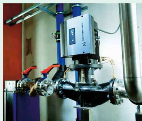
1 Kältepumpe einer Klimaanlage (Bürohochhaus) mit integrierter Drehzahlregelung und Datenbuskommunikation
