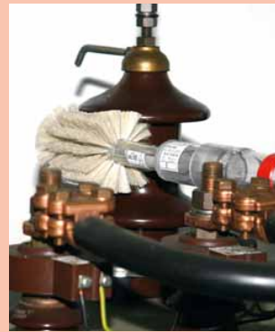
① Trockenreinigen von Isolatoren
