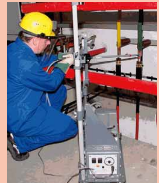
② Nachfüllen von Kabelimprägniermasse
