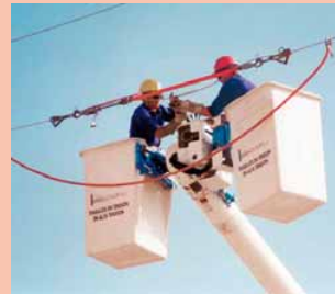
③ Reparieren von Leiterseilen
