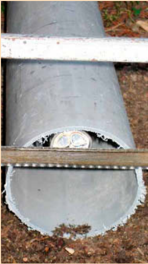
❶ Aufschlitzen des Schutzrohres mit der Bügelsäge führte zum Kurzschluss
