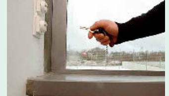
4 Fenster, Jalousien und Steckdosen sind in den Klassenzimmern nur mit Schlüsseln zu bedienen
